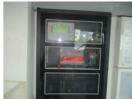
ภาพที่ 2.3-35 ตู้ควบคุมระบบแจ้งเหตุเพลิงไหม้
